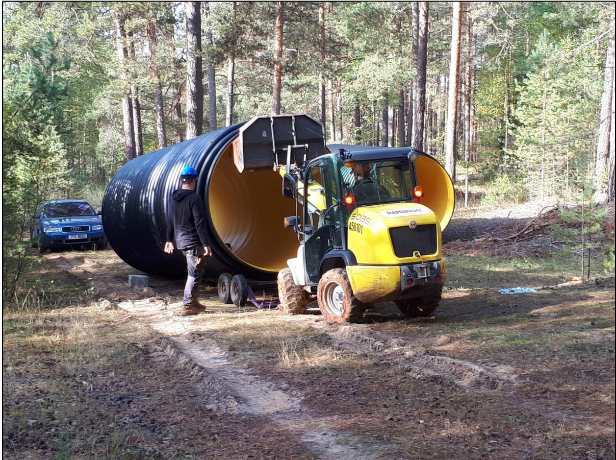
Foto 5. Piusa koobastikku paigaldatava turvatruubi elemendi ette valmistamine transpordiks maalustesse käikudesse. Foto: Lauri Klein.
